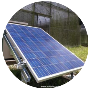
IBTE CAMPUS SOLAR PV, TUNGKU
