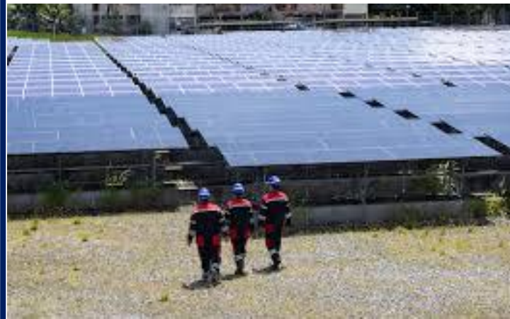
SOLAR FOTOVOLTAIK DI ATAS TANAH
